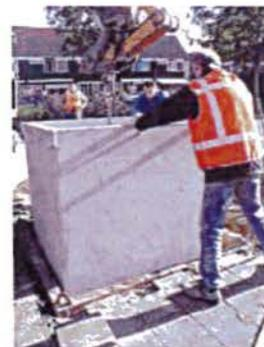
Sarà quindi realizzato lo scavo con i mezzi meccanici necessari, al termine del quale, con l'ausilio di autogrù verrà collocata la vasca da 5 mc prefabbricata in calcestruzzo armato. Seguiranno i necessari reinterri, la realizzazione delle pavimentazioni e la collocazione delle torrette di conferimento. Si concluderà con la fase di collaudo.
