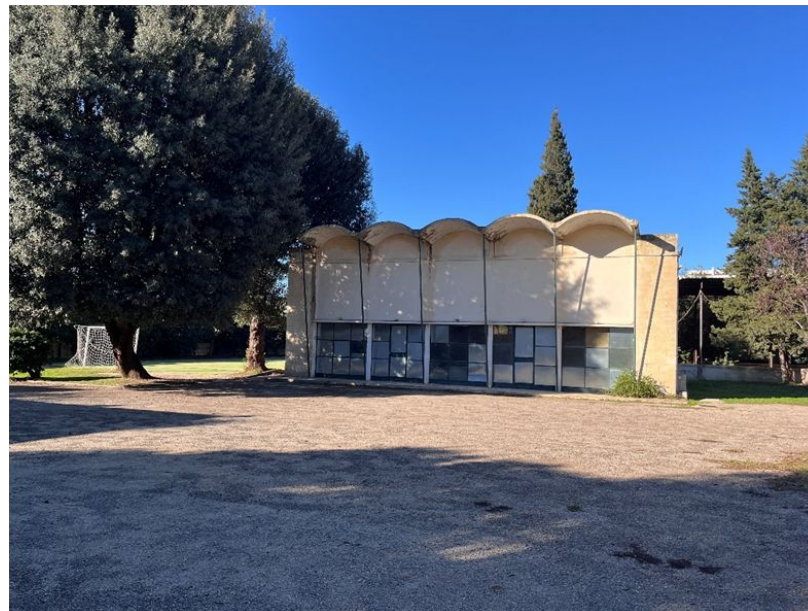
Edificio all'interno del Circolo Tennis
