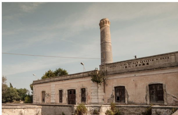
Idrovora di Frigole
